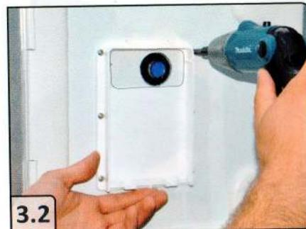
**3.2** De filterbehuizing moet minstens 5 mm van het deurframe worden aangebracht. Als montagehulp tussen deurframe en filterbehuizing 5 mm vlak materiaal houden.
